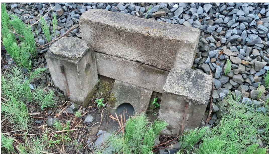
Foto č.4 - Propustek v km 2,885 - Pohled na výtok
